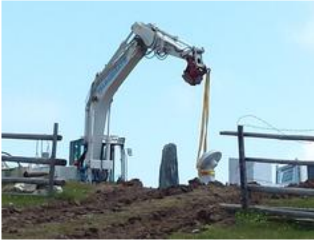
Abb. 3a Baugeschehen, ein Bagger als Kran (machine power)
