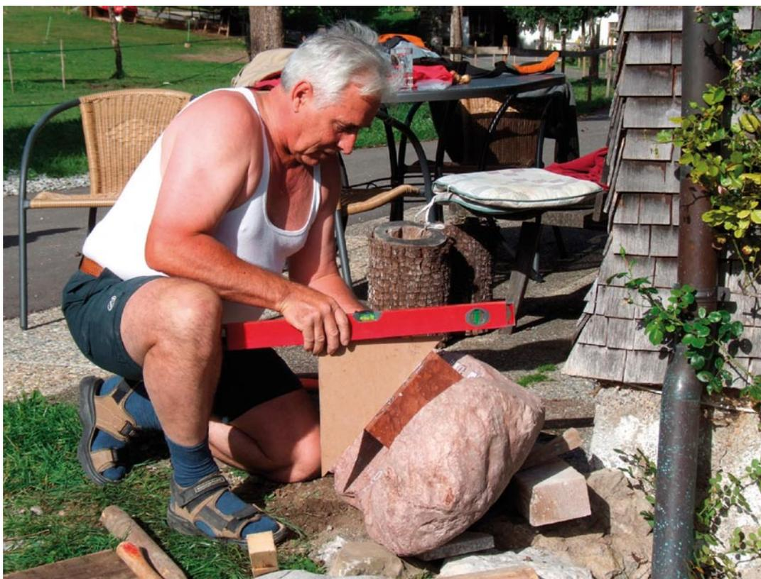
In diesem Bild erkennt man, wie unser Vereinsmitglied, Steinmetzmeister Norbert Ebli, die von ihm konzipierte und hergestellte Sonnenuhr mit Wasserwaage und einem auf die Polhöhe zugeschnittenen Holzdreieck auf die Neigung der Erdachse einstellt. Die schattenwerfenden Kanten werden damit zum
