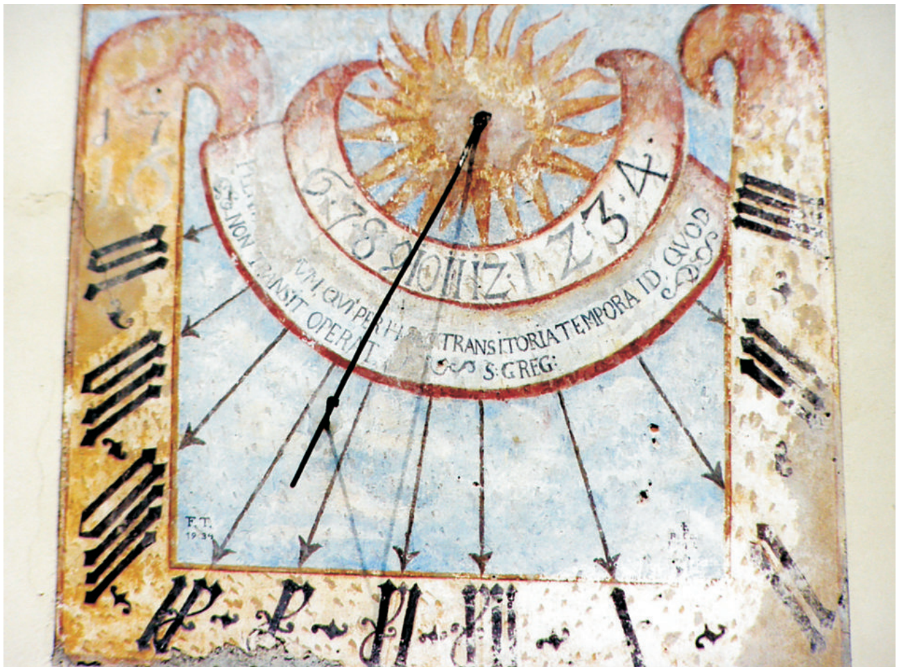
Abb. 1: Die Sonnenuhr vor Beginn der Renovierungsarbeiten
