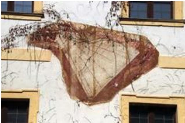
Abb. 9 DGC 1026 D-94501 Aldersbach, Kloster, Osttrakt, Innenhof, Ostwand; Typ: Wand-SU, 300×200 cm 2
