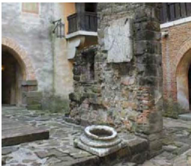
Abb. 9 Die falsch (nämlich vertikal) montierte Horizontaluhr im Schloss Görz, 2013.
