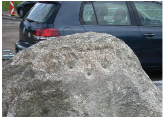
Abb. 4 Die Aufnahmebohrungen für die drei Ankerbolzen des Heliochronometers sind hergestellt.
