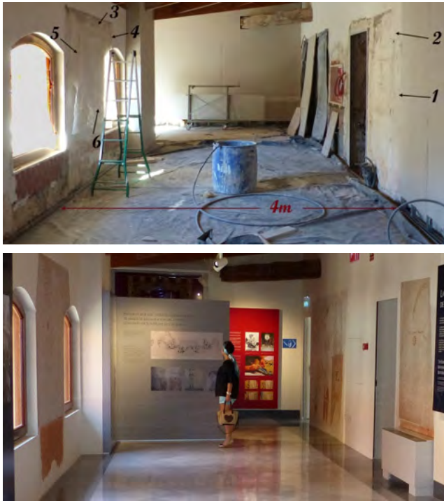
Abb. 2 Der Kreuzgang vor (oben) und nach seiner Restaurierung (unten).
