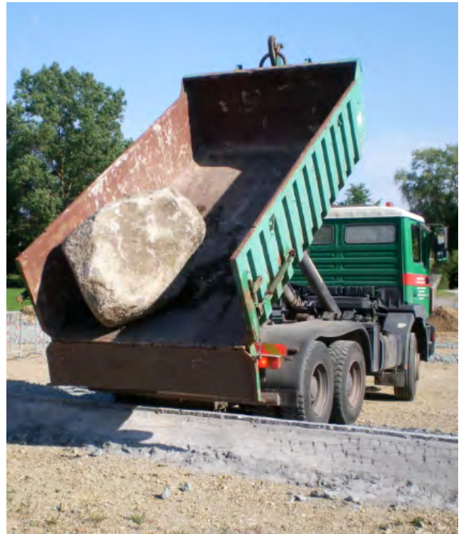
Abb. 3 Der Granitfindling rutscht vom Lkw herab an seinen Aufstellungsort.
