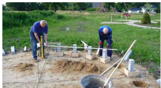
Abb. 2 Die Stundensteine werden gesetzt.
