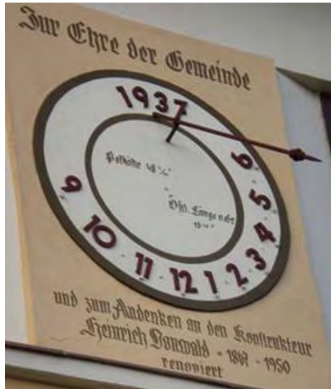
Abb. 7 Die Sonnenuhr am EVN-Gebäude. Polhöhe und östliche Länge sind angegeben.
