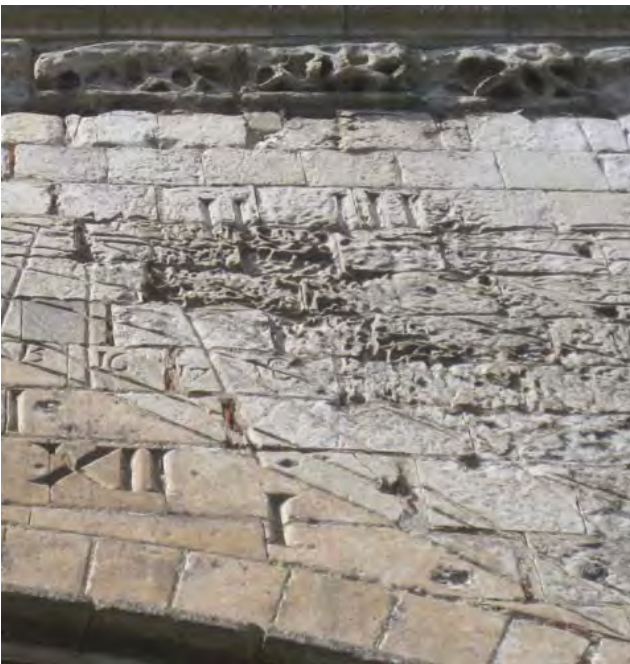
Abb. 1 Schäden durch Verwitterung.
