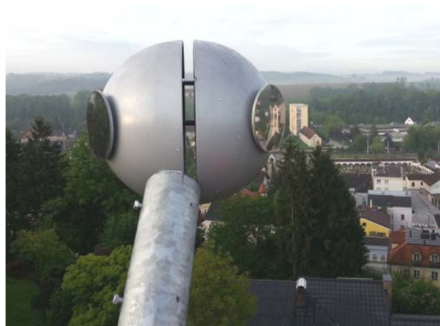
Abb. 2 Gnomon, Durchmesser 300 mm, mit Spiegeln und Schlitz 20 mm am Südmeridian
