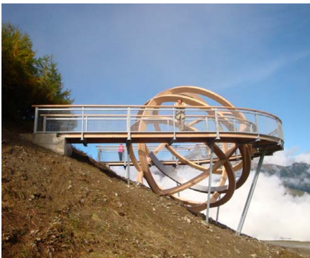
Abb. 2 Ansicht von Südosten (noch ohne Treppe)
