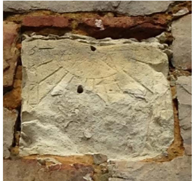
Abb. 1 Stark vom Verfall bedrohte Sonnenuhr aus Kalkstein an einer Wehrkirche in Thiérache
