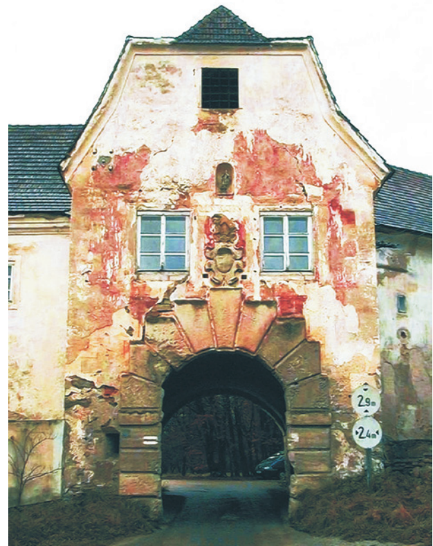
Torturmfassade vor der Restaurierung
