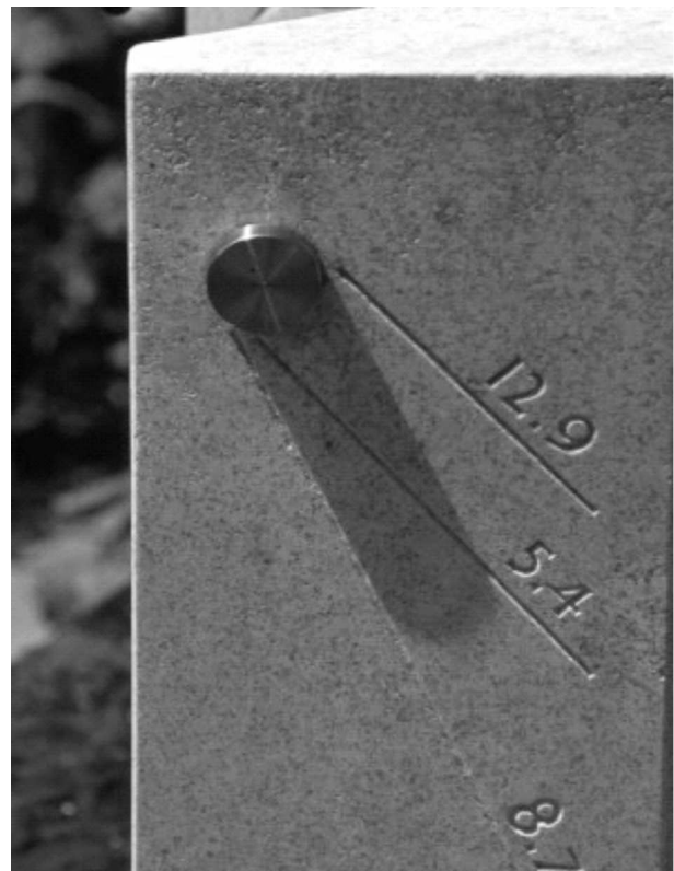
Zylinderförmiger Schattenwerfer an der östlichen Außenfläche zur Datumsablesung
