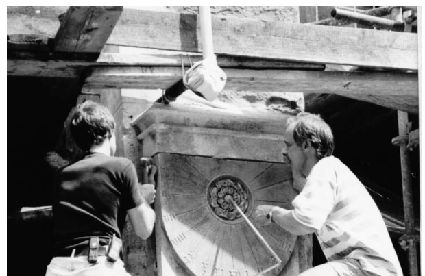
Zwei Bilder vom Einrichten der restaurierten Sonnenuhr am Chorpfeiler. Foto:J.Vonasek
